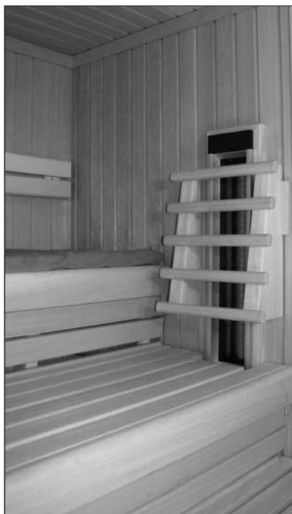
Einbau eines 500 Watt Strahlers mit einer Holzverkleidung auf der 2. Stufe der Sauna.
