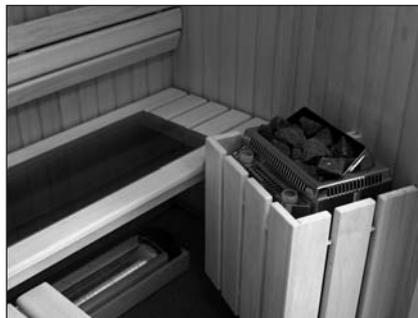
Aufbau eines 750 Watt Strahlers auf dem Boden unter der Sitzbank, welche mit einer Glasplatte ausgespart ist.
