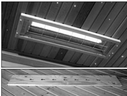
Bild oben: Einbau eines 1300 Watt Strahlers in die Decke.
