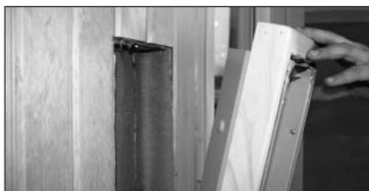
Das Einbaugehäuse (hier mit Holzverkleidung versehen) wird am Holzausschnitt an den vorgegebenen Montagelöchern festgeschraubt.
