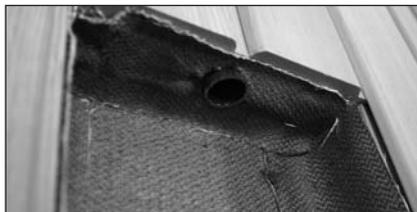
Der Holzausschnitt ist mit einer Brandschutzmatte und dem Brandschutzband ausgekleidet. Hier sieht man auch den Lüftungskanal wie auf Seite 8 beschrieben.
