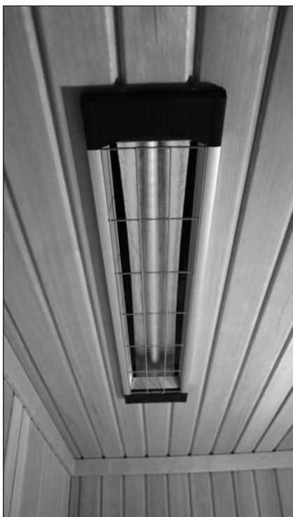
Einbau eines 1300 Watt Strahlers in die Decke.
