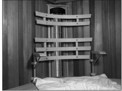
Einbau eines 500 Watt Strahlers in die Ecke der Sauna mit Rücken- und Armlehne.
