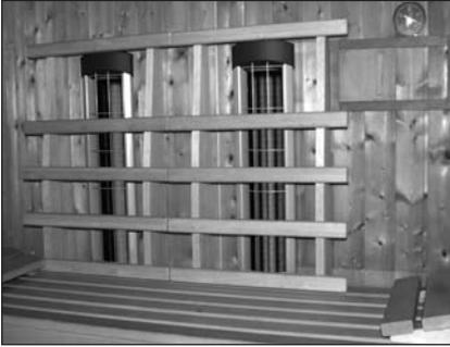
Senkrechter Einbau der 500 Watt Strahler mit Rückenlehne als Schutzvorrichtung.
